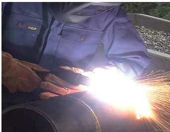
Odstranění svarové housenky
