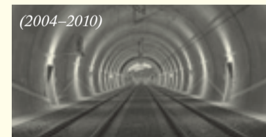
Nové spojení (tunel pod pražským Vítkovem)
