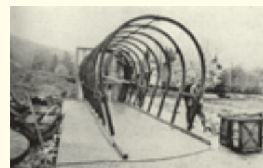
POKUSNÁ OBEZDÍVKA PŘI STAVBĚ PŘIVADĚČE Z ŽELIVKY
