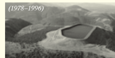
Přečerpávací vodní elektrárna Dlouhé Stráně
