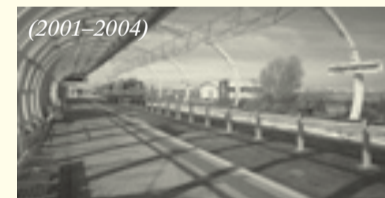
Tramvajová trať Hlubočepy–Barrandov, Praha
