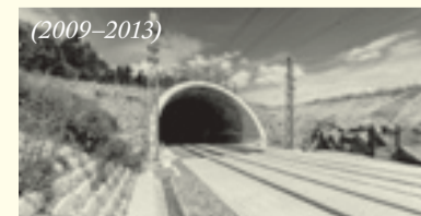
Modernizace trati Votice – Benešov u Prahy
