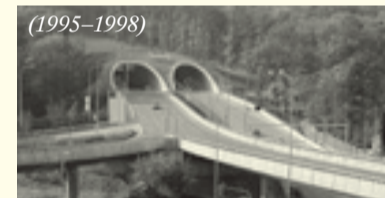
Silniční tunely VMO Pražská radiála v Brně
