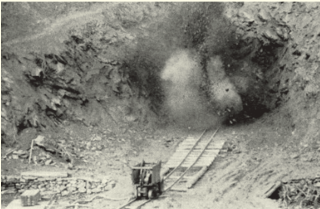
Září 1964: první odpal na pokusné štolě vodovodního přivaděče z Želivky do Prahy Repro z knihy: Želivka tunelem do Prahy
